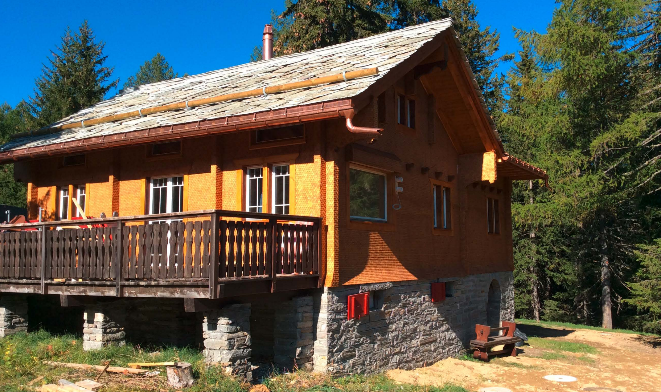
Rothwald: Komplette Renovation eines Chalets
